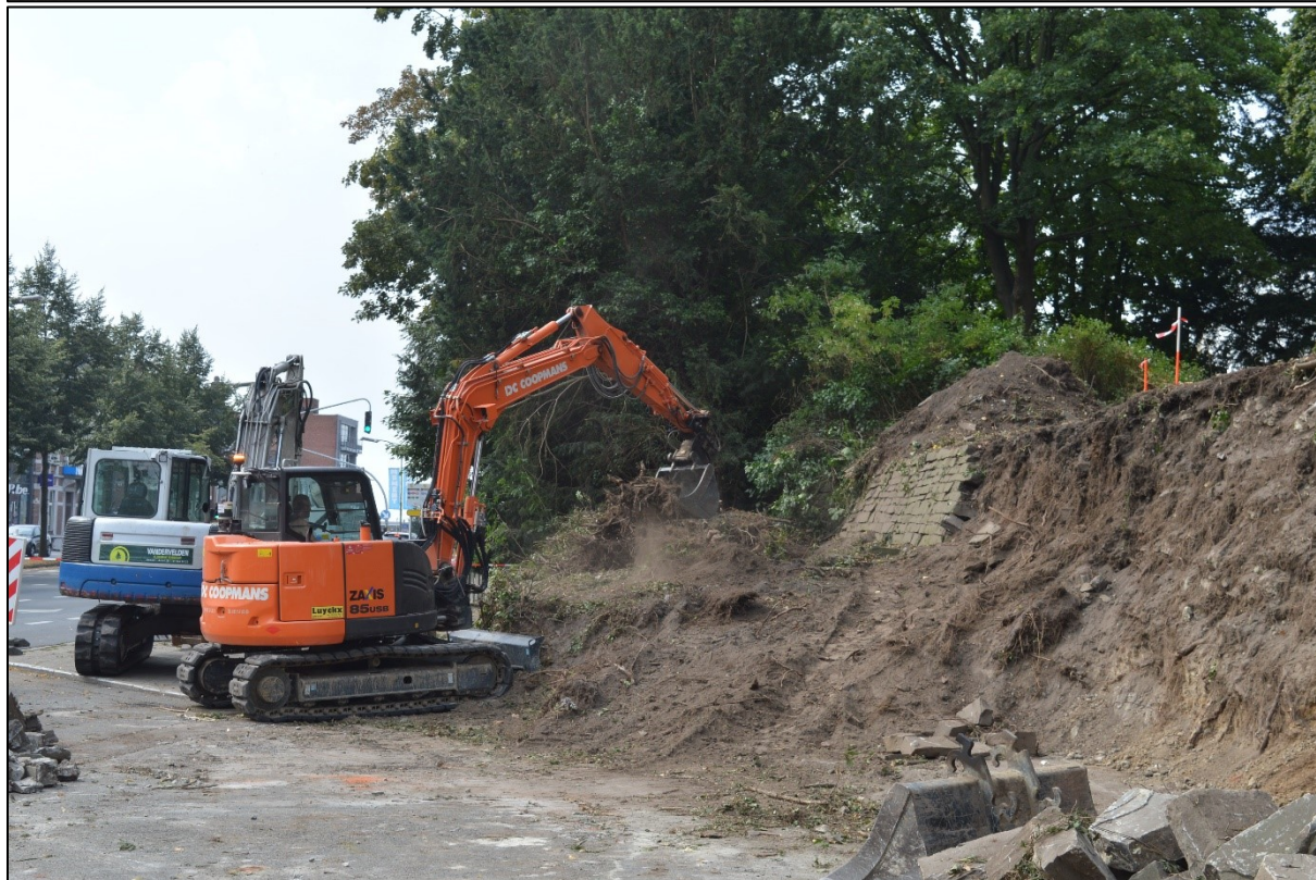
Afb. 47-48: Zicht op het profiel aan de westzijde na het zagen van de bomen en het wegnemen van de bestaande muren, en zicht op het wegnemen van de natuurstenen keermuren aan de oostzijde (zijde Eeuwfeestwal) (Bron: Aron bvba, dd. 5/7/2018, 2018G34).
